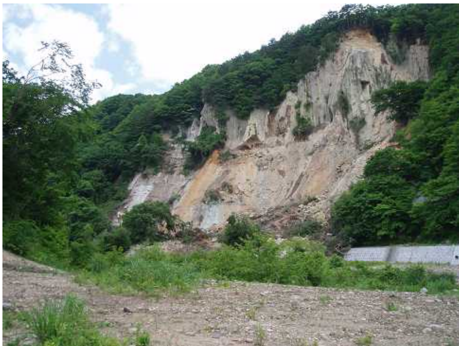
写真 7.16 井川左岸で発生した土砂くずれ
