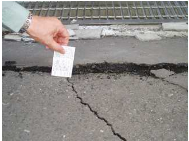
写真 7.3、7.4 栗原市役所別館の玄関先の状況。キレツと段差が発生
