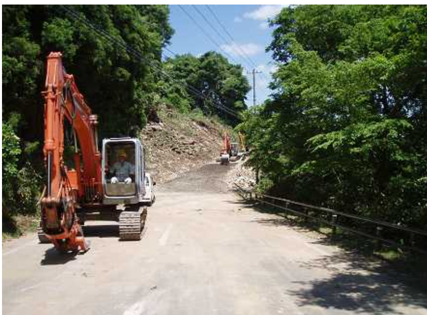
写真 7.19 一関市の国道 342 で発生した土砂くずれの復旧工事の状況
