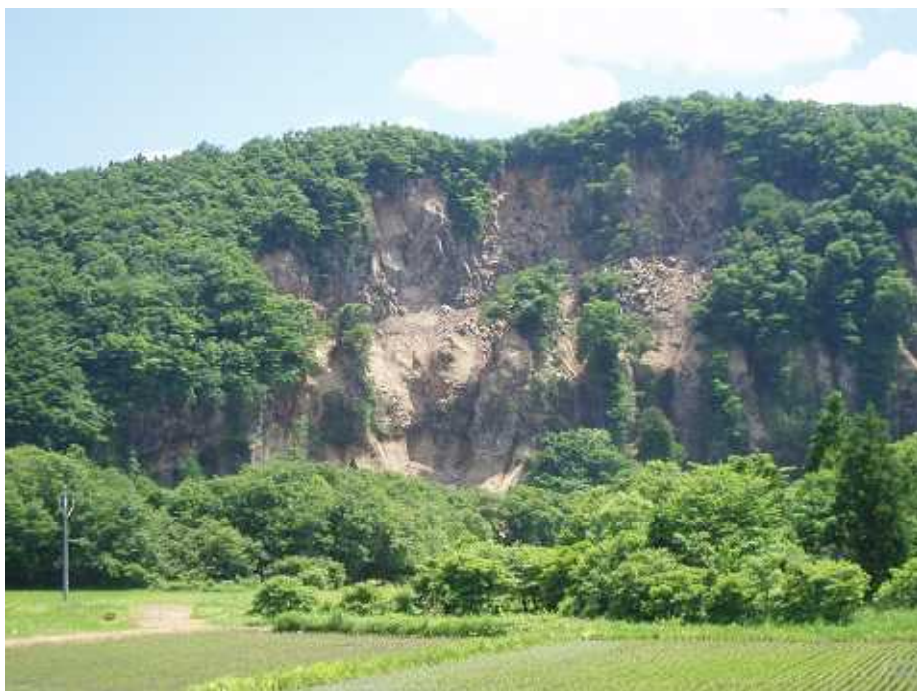
写真 7.17 磐井川右岸で発生した土砂くずれ
