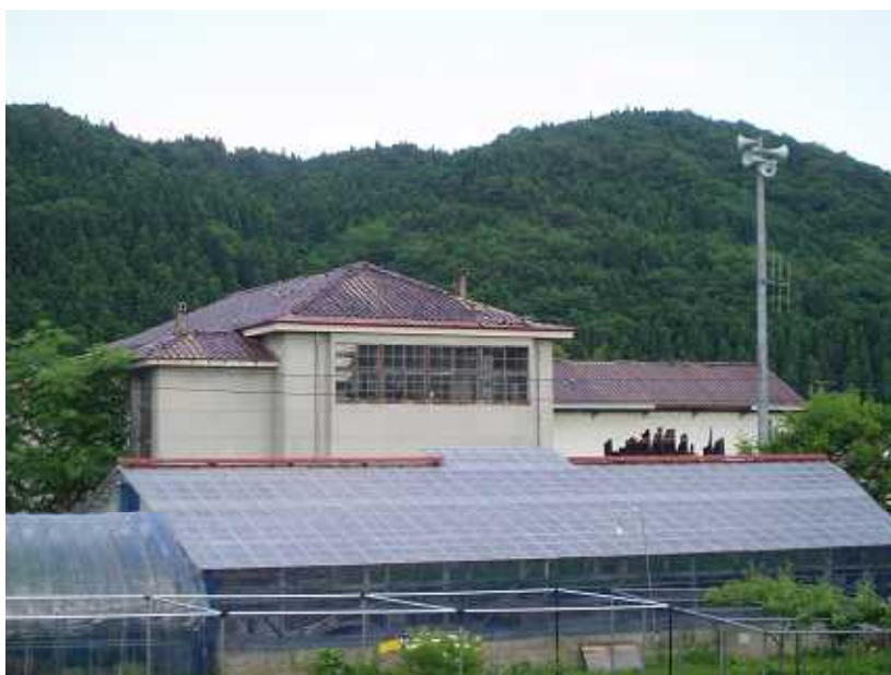
写真 7.6 栗原市栗駒町岩ヶ崎付近の建物屋根のむねの状況
