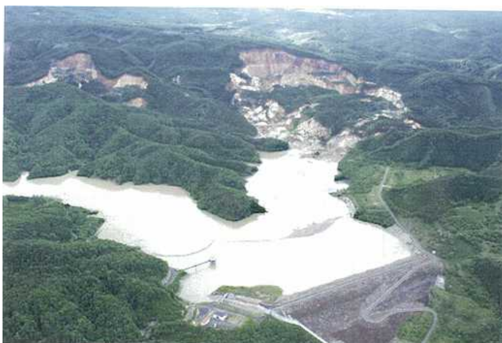
写真 7.1 荒砥沢打ダムの状況（読売新聞より）
