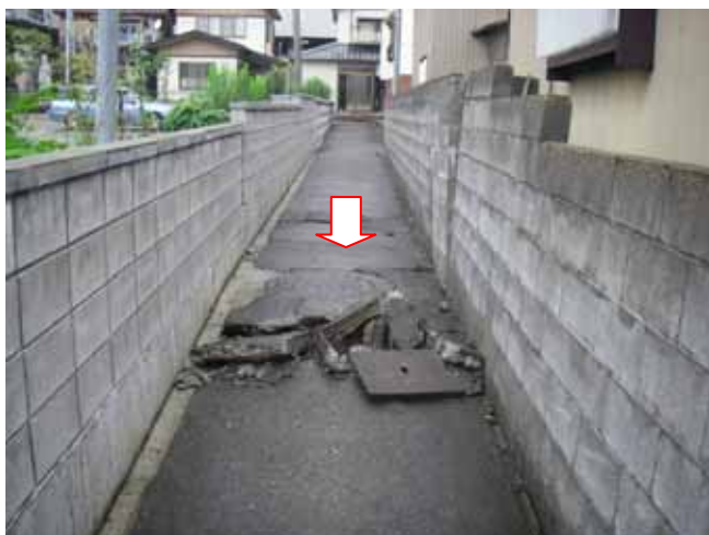
写真 4.3.10、11 液状化（？）し矢印の方向（下り勾配）に地盤が移動しアスファルトが破損
