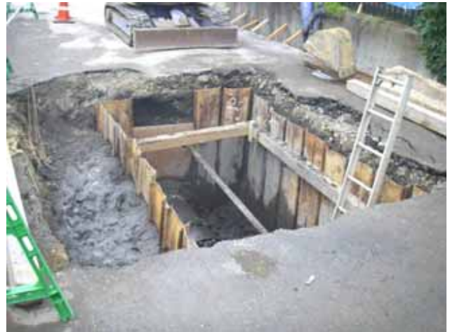
写真 4.3.17、18 水道管の破損による漏水と水道管の復旧作業現場
