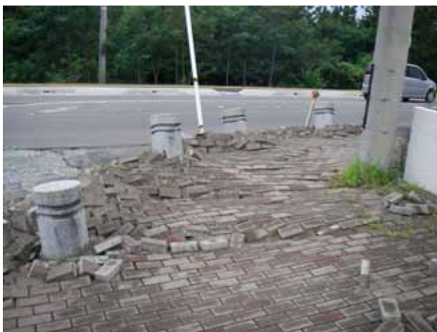
写真 4.3.8、9 液状化によるインターロッキングブロックの変状
