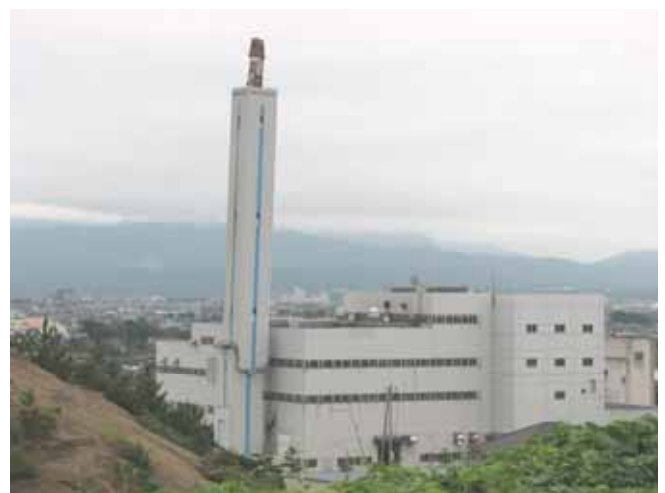
写真 4.3.20 柏崎クリーンセンターの煙突被害（神奈川大、荏本孝久氏撮影）
