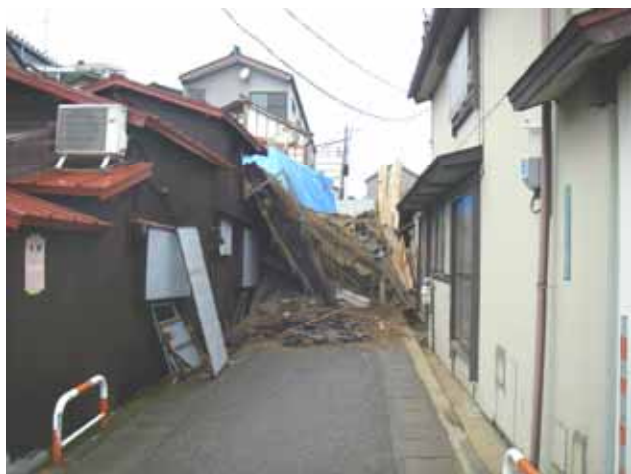
写真 4.3.13、14 家屋の倒壊により通行不能となった路地
