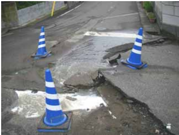
写真 4.3.17、18 水道管の破損による漏水と水道管の復旧作業現場
