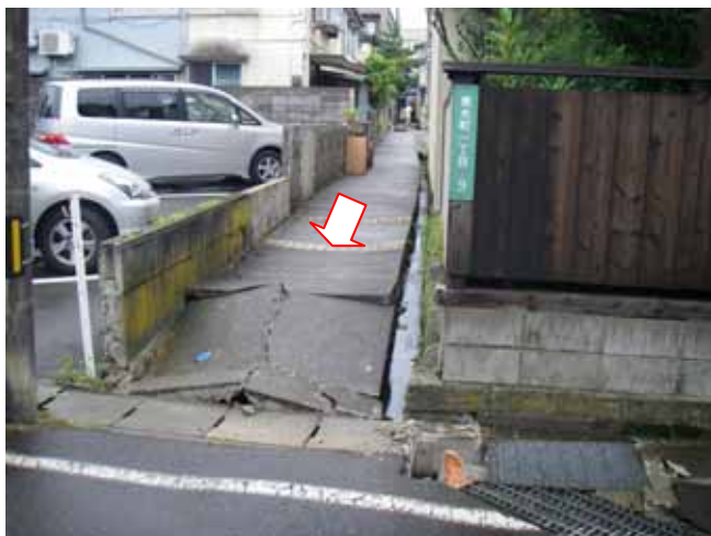
写真 4.3.10、11 液状化（？）し矢印の方向（下り勾配）に地盤が移動しアスファルトが破損
