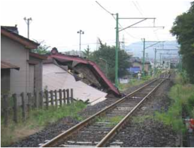
写真 4.3.15 倒壊家屋が線路上へ（越後線）
