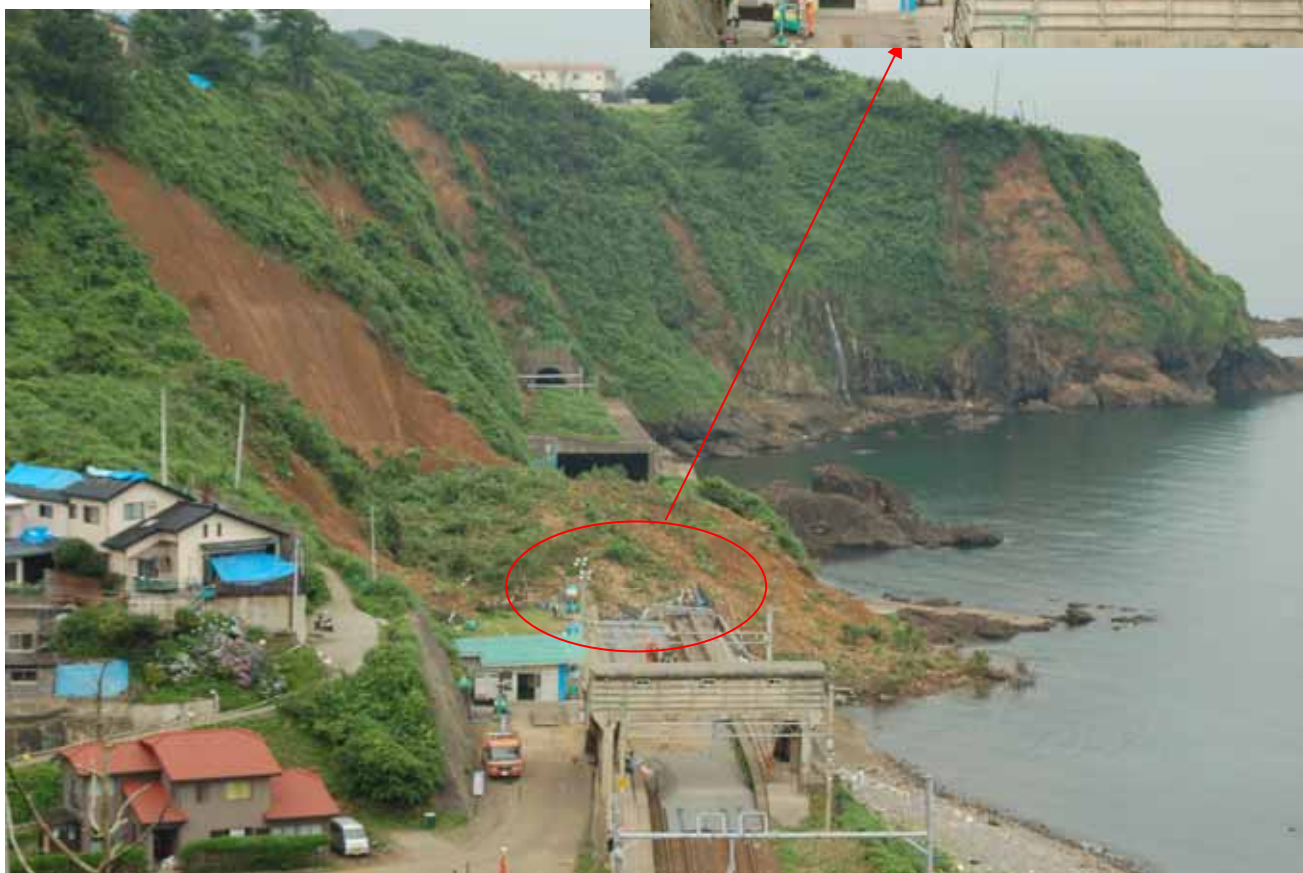
写真 4.3.22、23 青海川駅付近の斜面崩壊（右上はボーリング作業場所の拡大写真） (神奈川大、Rahimian 氏撮影)
