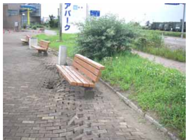
写真 4.3.8、9 液状化によるインターロッキングブロックの変状
